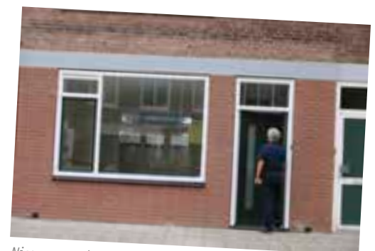
Nieuwe gevel aan de Beatrixstraat
